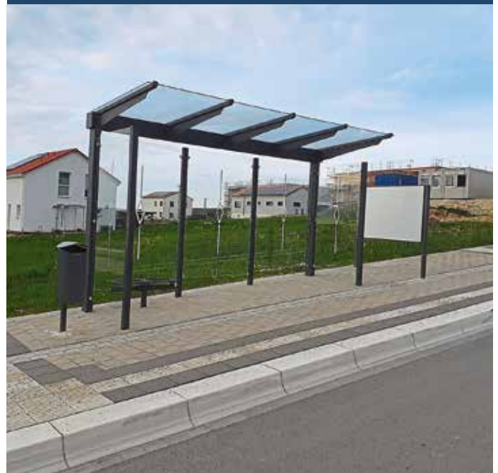
Die Bushaltestelle Rapunzelstraße im Neubaugebiet Blumenberg-West ist frisch fertiggestellt. Foto: Christian Mayer
