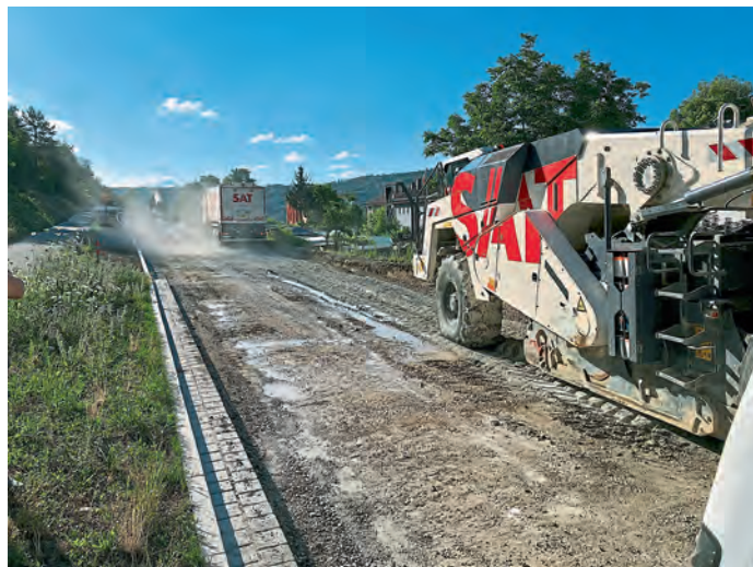
Bei den Bauarbeiten des Staatlichen Bauamtes Ingolstadt in der Kipfenberger Straße sind zusätzliche Arbeiten erforderlich. Dadurch verschiebt sich der Abschluss der Sanierung. Foto: Staatliches Bauamt Ingolstadt
