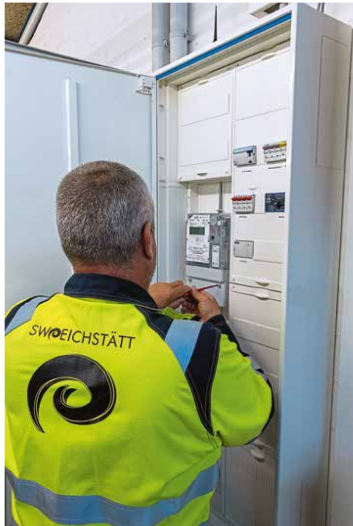
Schritt für Schritt werden die Stromzähler zu digitalen Zählern getauscht.
