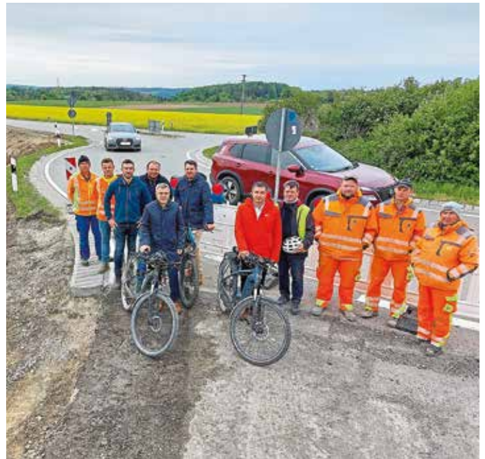
Alle Bauherren des Bauprojekts feierten Anfang Mai gemeinsam den Baustart.
