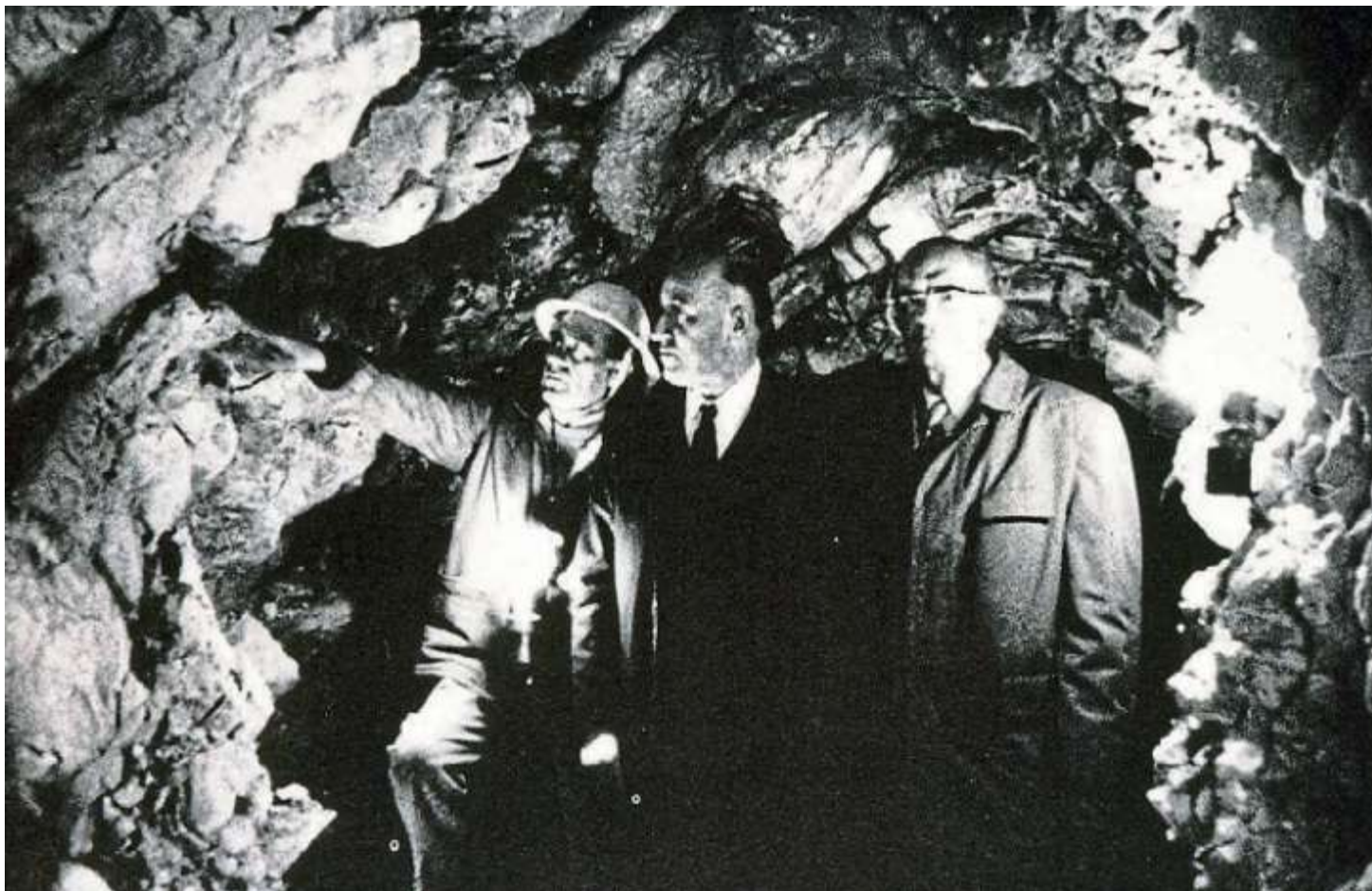
Oberbürgermeister Dr. Hans Hutter zu den Anfängen der Partnerschaft in der Pesciara in Bolca.
