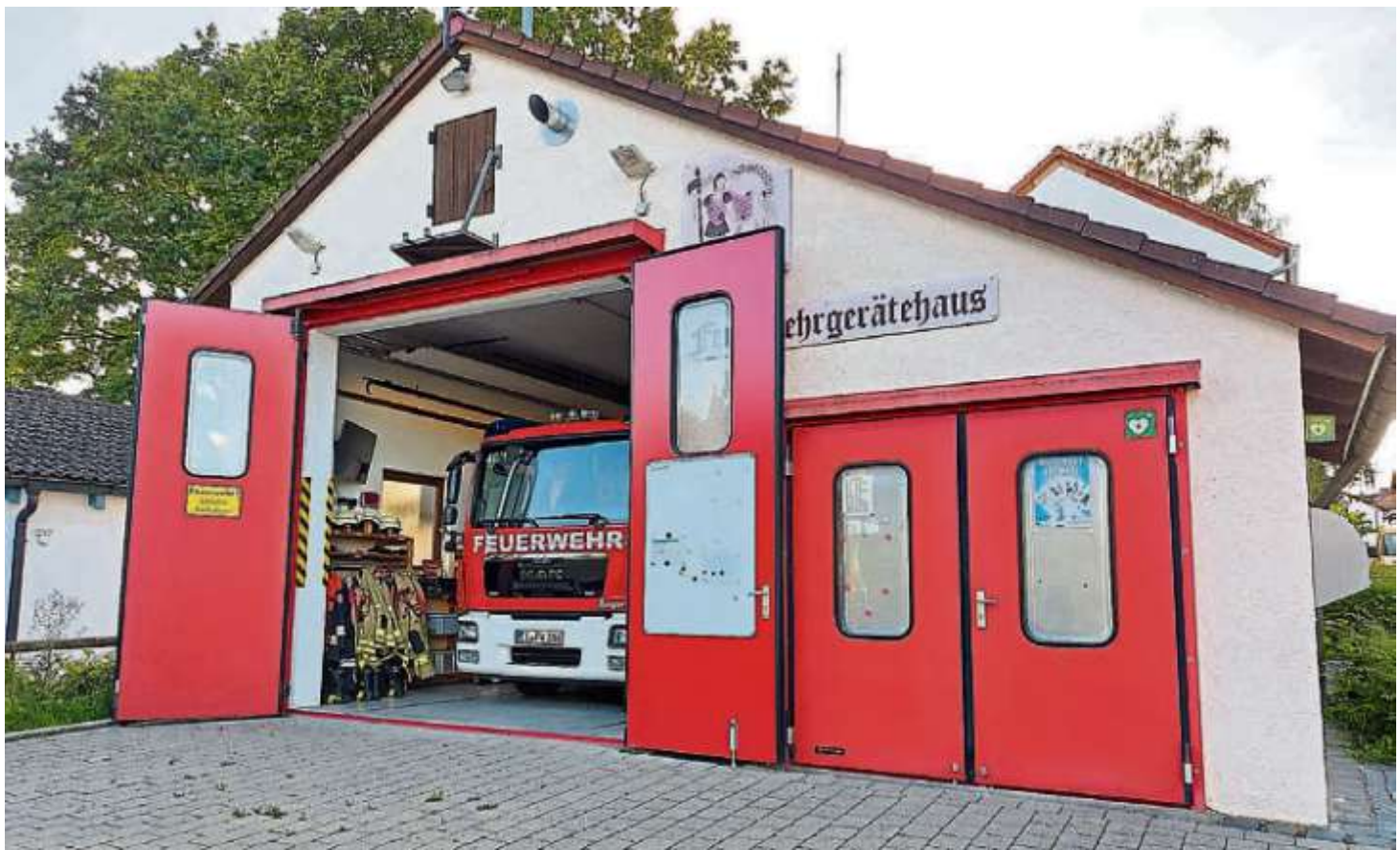
Das Feuerwehrhaus im Herzen des Dorfs ist Anlaufstelle für Übungen und Einsätze – und Begegnungsort für Feste und Feiern. Foto: Schmidt/Stadt Eichstätt
