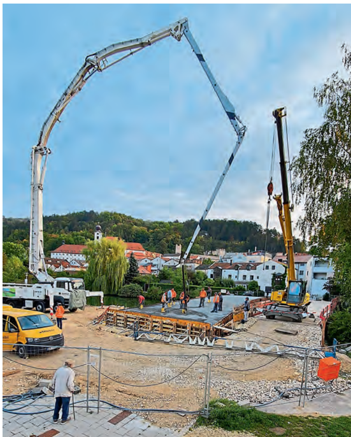
Mit 130 Kubikmetern Spezialbeton wurde Anfang Oktober der Brückenkörper des neuen Herzogsteges betoniert.
