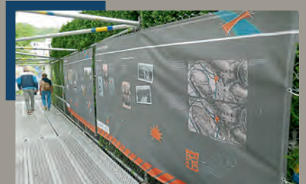
Herzogsteg: Gute Fortschritte auf der Baustelle
