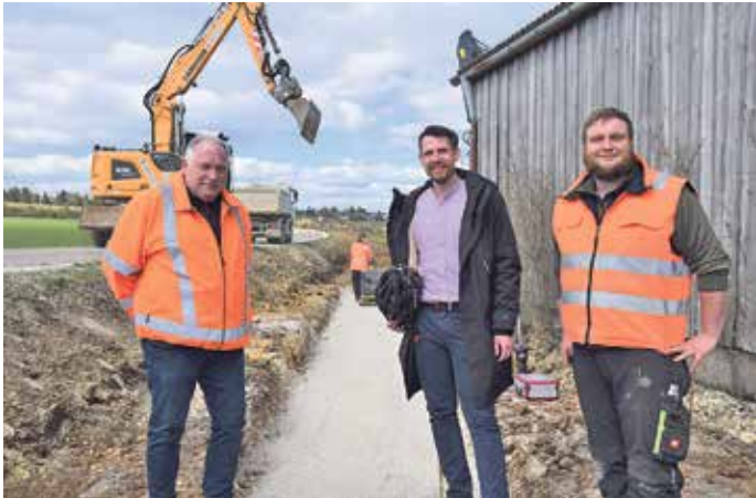
Verschafften sich ein Bild von der Lage vor Ort: Oberbürgermeister Josef Grienberger (Mitte) und Jürgen Kraus von den Stadtwerken (links) im Gespräch mit Mitarbeitern der Firma Swietelsky.
