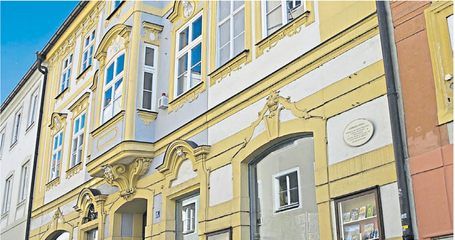
Die Baustelle in der Gabrielstraße wird gleich nach Ostern beginnen.
