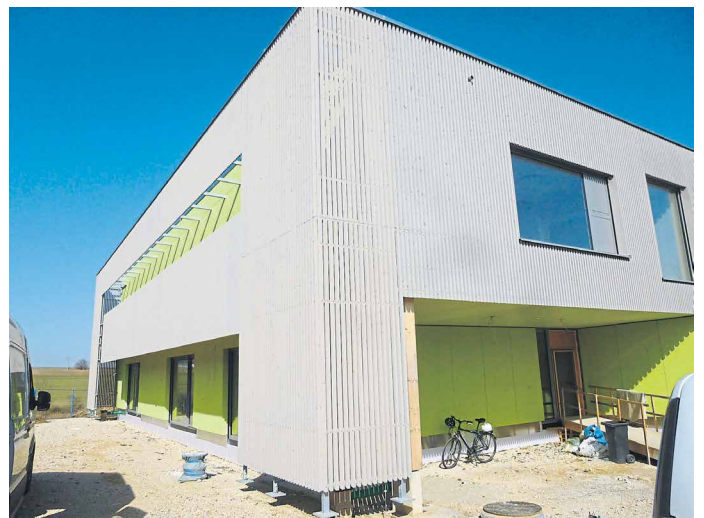
Im Herbst 2022 sollen bereits die ersten Kinder in der neuen Kindertagesstätte auf dem Seidlkreuz spielen und lernen dürfen. Aktuell ist das Bauvorhaben gut im Zeitplan, 2,7 Millionen sind dafür im Haushalt veranschlagt.
