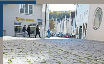
Baumaßnahme Pfahlstraße beginnt Seite 10
