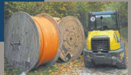
Glasfaserausbau der Telekom in der Eichstätter Altstadt
