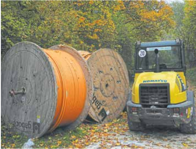
Die Glasfaser-Ausbauten im Stadtgebiet laufen bereits.
