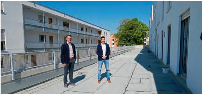
Bei einem Termin vor Ort überzeugten sich Oberbürgermeister Josef Grienberger (links) und Marcus Scheliga (rechts) vom Fortschritt auf der Baustelle.
