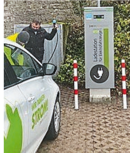
Inbetriebnahme Ladesäule Kolpinghaus in Eichstätt am 15. Dezember.
