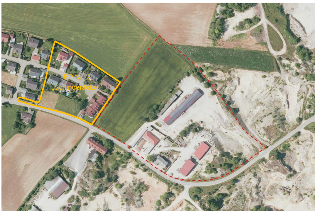
Abb. 4: Luftbild mit Abgrenzung des Plangebietes (rote Strichlinie) und angrenzendem Bebauungsplan (orangene Linie)
