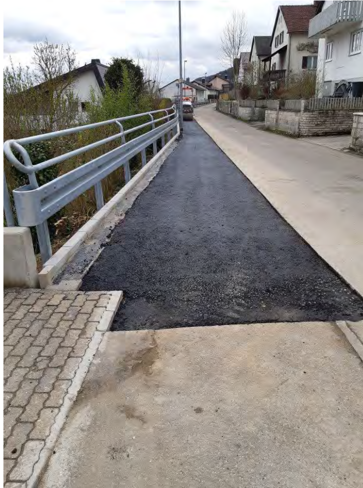
• Stützmauer Auf der Alm
