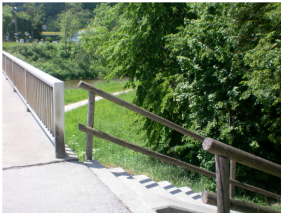
Treppe mit Schieberinne an der Pirkheimerstraße, zwei Wege in zwei Ebenen ohne vernünftige Verknüpfung
