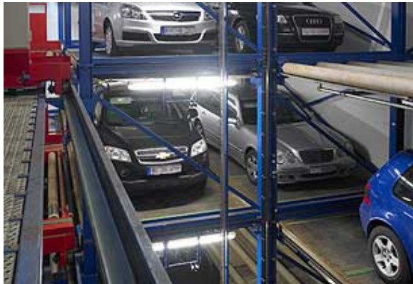
mechanische Parkgarage in Duderstadt (Foto: Fa. Lödiges)
