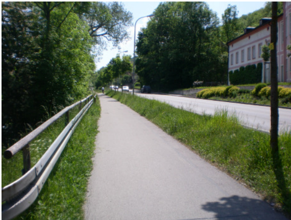
Radweg auf der ehemaligen Bahntrasse
